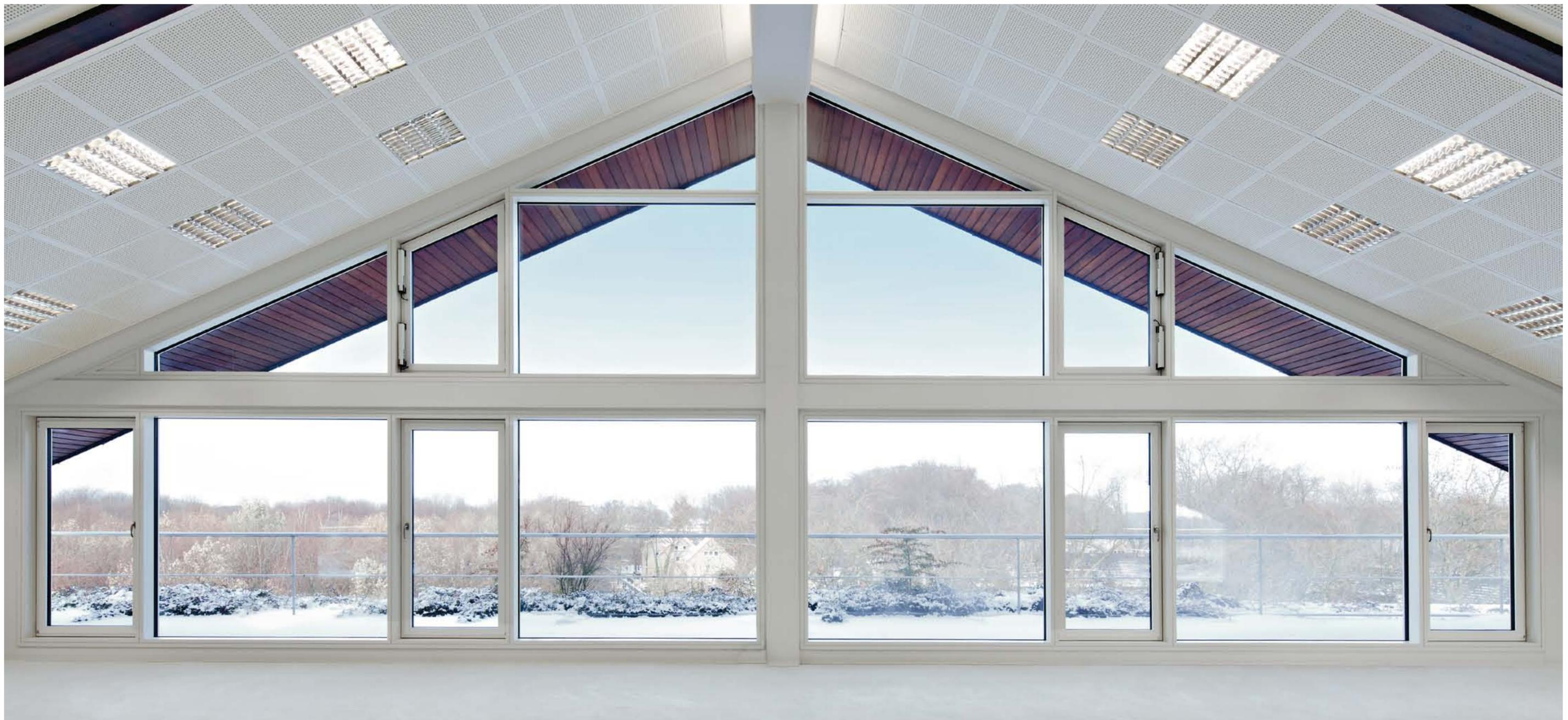
Kreative und großzügige Gruppenbüros, wie z. B. oben im Foto zu sehen, müssen nicht zwangsläufig hohe Nebenkosten nach sich ziehen, wenn man eine Dreifachverglasung mit einem U-Wert von 0,6 und eine 30 cm starke Wärmedämmung im Dach einsetzt.
